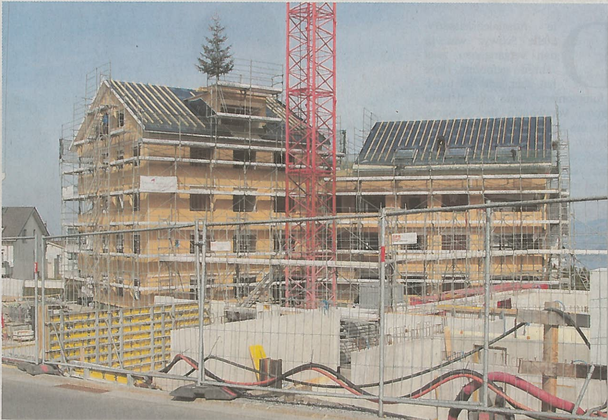
Zwei der insgesamt vier Holz-Wohnhäuser stehen bereits
